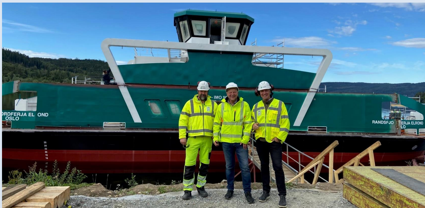
Monteringen av Randsfjordferja er i gang (Bilde 19. august 2021)
